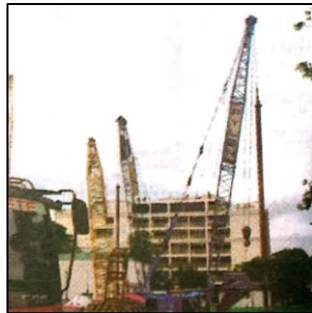
รูป 2.4 การตอกเสาเข็ม
